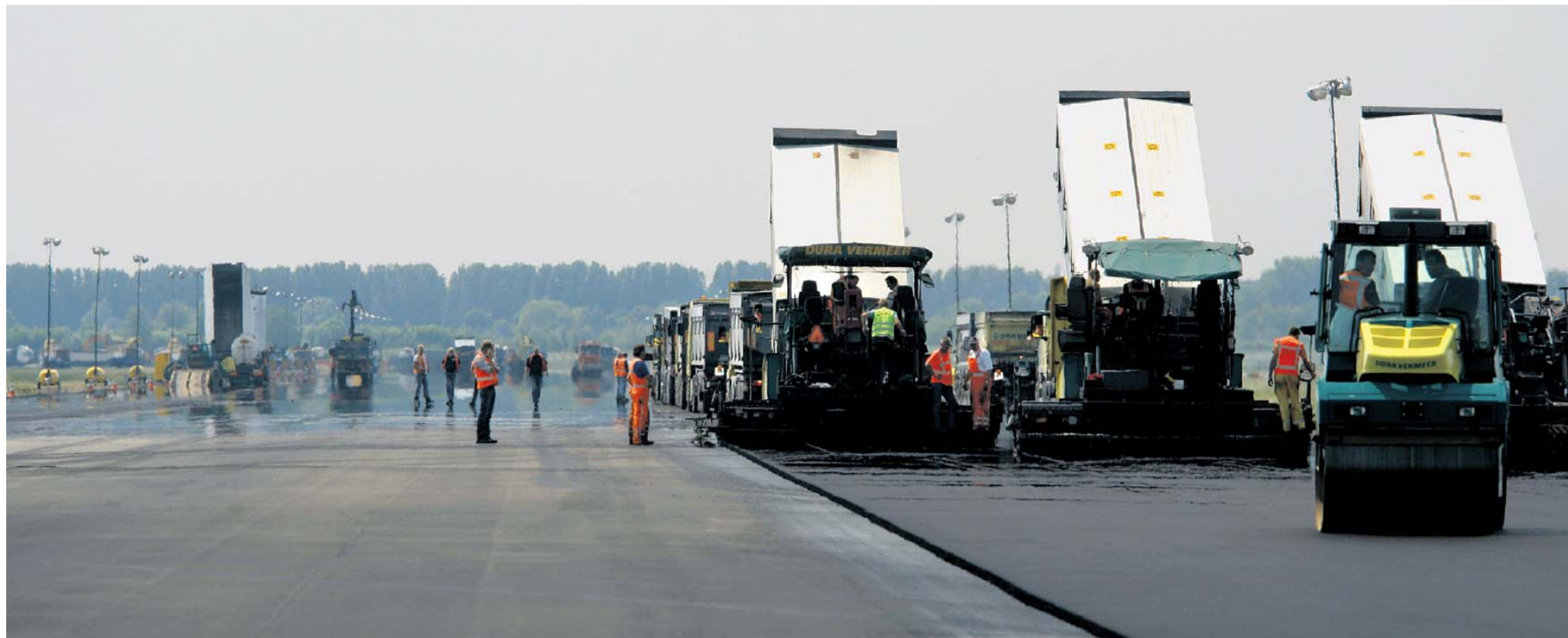
Anderhalve week geleden is de start- en landingsbaan van Rotterdam Airport opnieuw geasfalteerd en zijn de kabels voor de verlichting vernieuwd. Foto NRC Handelsblad, Rien Zilvold
